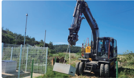
기상관측장비 설치 현장
