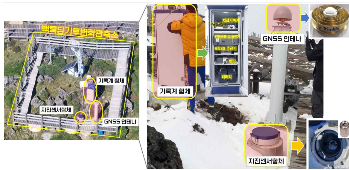
< 한라산 정상(1,905m) 화산관측소 현장 및 관측장비 >
